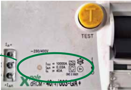
FI-Schutzschalter allstromsensitiv: Für den Endstromkreis, also Steckdosen, sind FI-Schutzschalter mit 30 Milliampere Auslösestrom vorgeschrieben. Dieser Wert kann am FI abgelesen werden.
